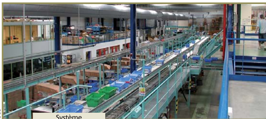
©CC Système de convoyeur pour la préparation de commandes dans l'entrepôt de Beauvais.
