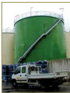
Le site de Venette comprend quatre cuves de stockage, l'une de 2.500 tonnes et les trois autres de 1.250 tonnes.
